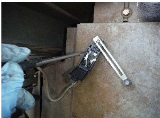
交換作業状況
